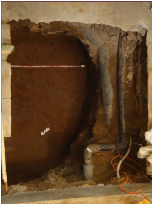
Foto 7. Imatge de la UE 20, i cota final d'excavació.
