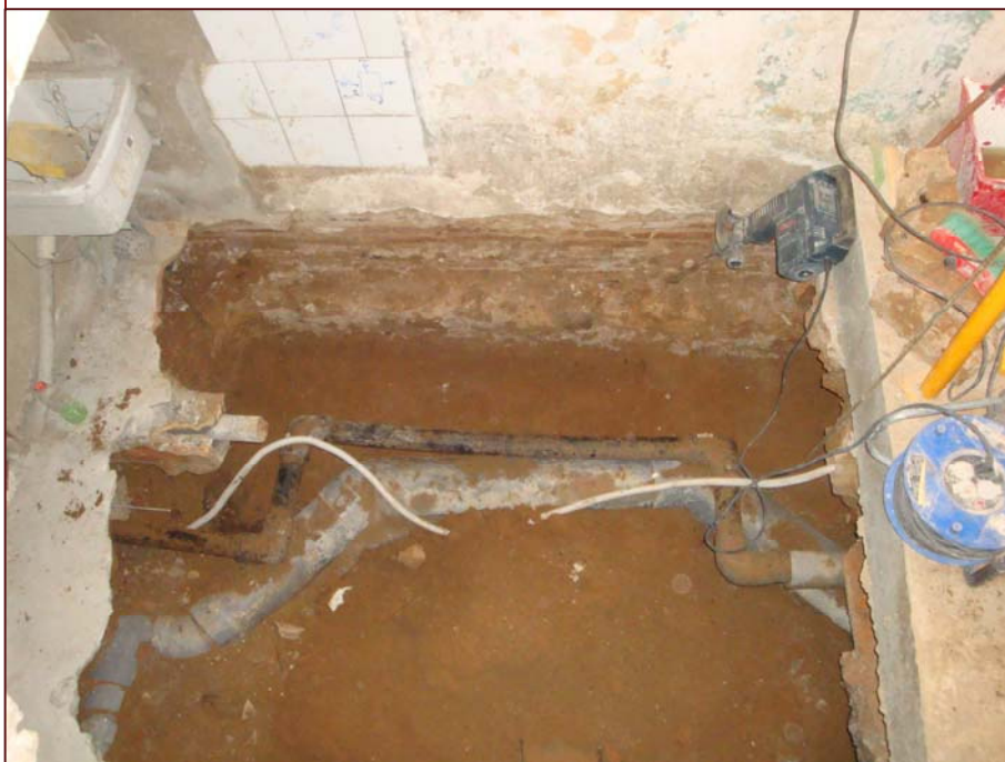
Foto 10. Vista general de la UE 18 i cota final de l'ampliació de la excavació.
